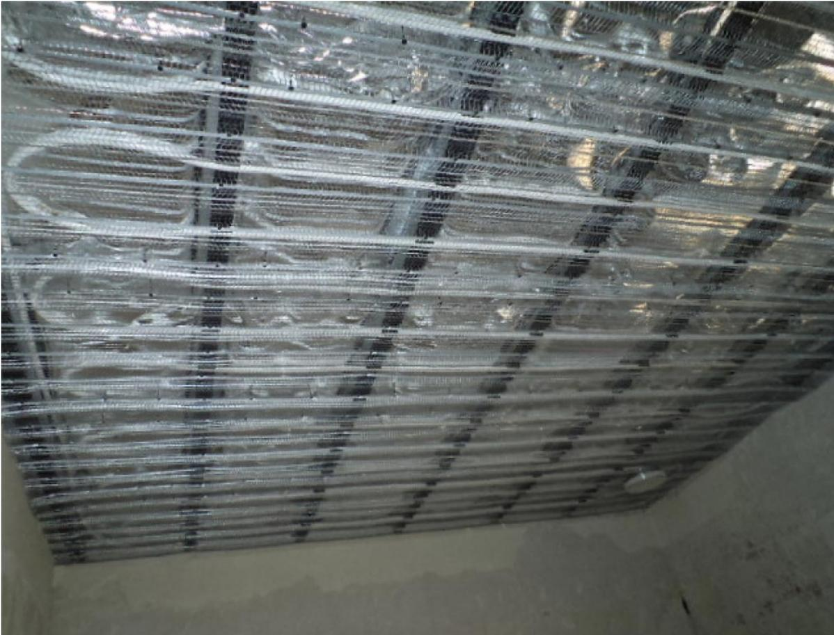
*Plafond rayonnant à eau fonctionnant suivant le même principe qu'un plancher à eau mais sans inertie (maisons BBC) et sans contrainte de hauteur au sol. Idéal en rénovation, hauteur perdue maximum 4 cm.*
