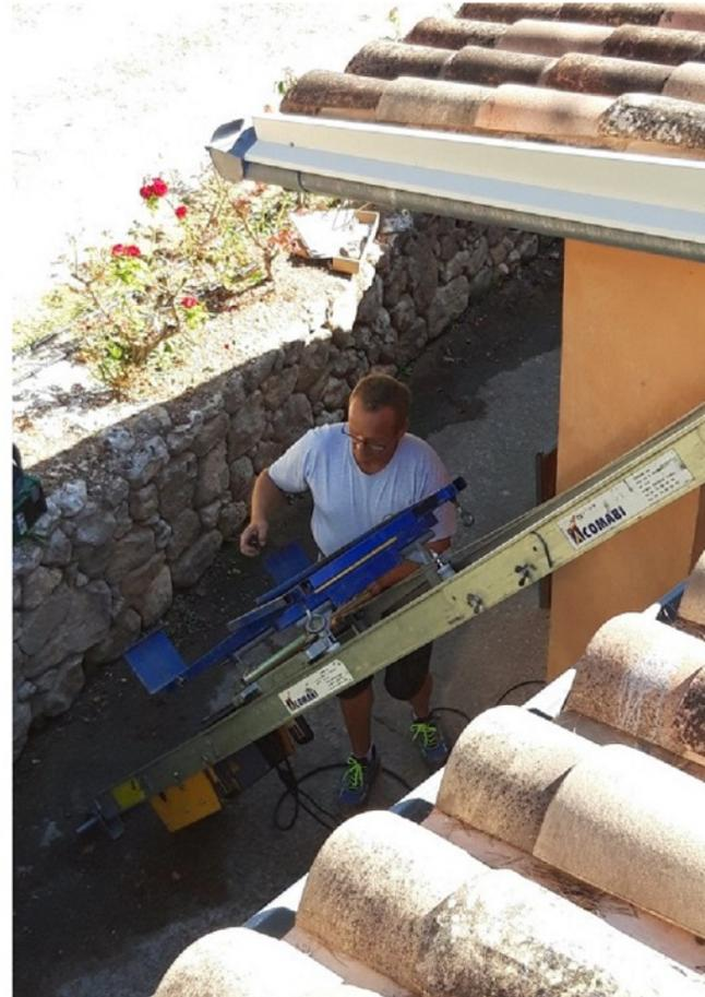
*C'est dans un très beau domaine que Soleil vert a réalisé une installation solaire thermique, adaptation réalisée sur une chaudière gaz avec production d'eau chaude sanitaire, la production d'eau chaude solaire en amont de l'installation existante permet d'écourter les cycle de fonctionnement de la chaudière gaz, complètement autonome en période estivale, la chaudière est complètement arrêtée afin de réduire la consommation de gaz propane annuelle. Soleil vert 0659471056*
