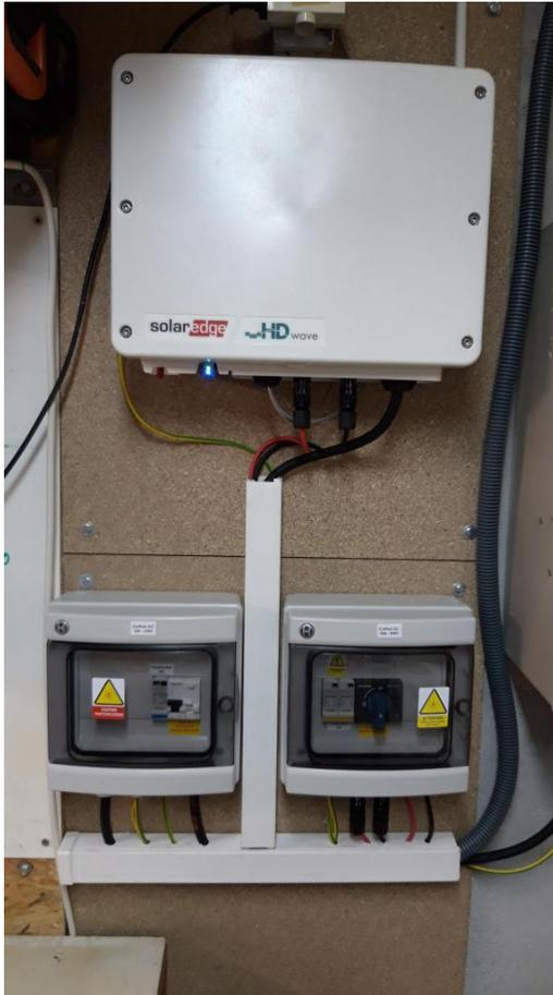
*Cette installation, composée de 10 panneaux 300 Wc de marque DUALSUN, est pilotée par un onduleur et optimiseurs SOLAR EDGE, un compteur de consommation a été ajouté. Il est ainsi possible de visualiser la production panneau par panneau, la consommation et la production en temps réel et le taux d'auto-consommation.*
