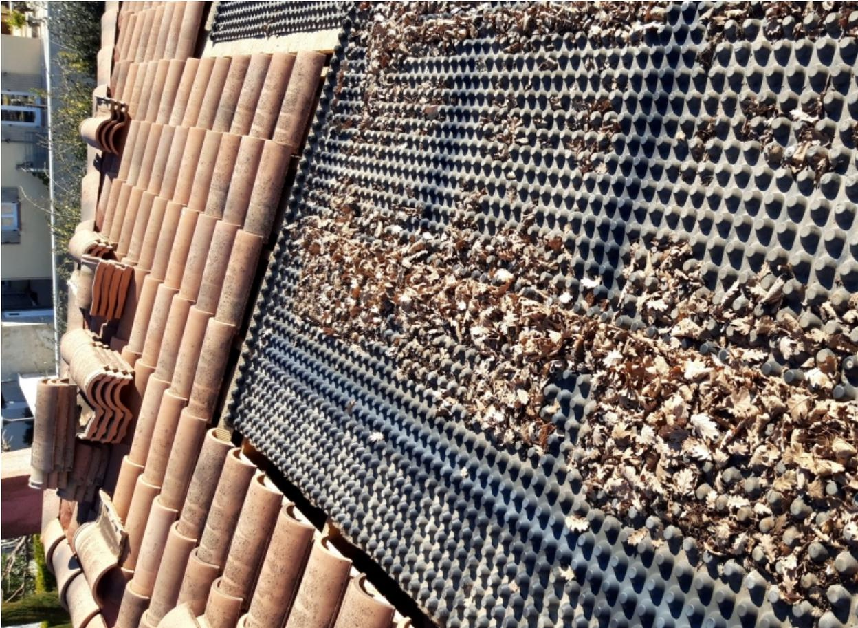
*Cette installation, réalisée en 2010 par une société aujourd'hui disparue, a été réalisée avec une membrane PEHD PV TECH qui présente à terme des problèmes de fissurations des alvéoles, entraînant systématiquement des fuites. Les panneaux et les membranes ont été démontés pour mettre en lieu et place un bac acier COVEO et la structure porteuse adaptée.*
