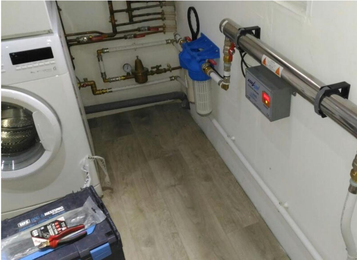
*Installation d'une station de filtration et de désinfection par UV d'une arrivée d'eau sanitaire alimentée par le canal de provence, afin de garantir une eau propre à la consommation d'un point de vue sanitaire, nous avons réalisé cette installation à la demande de nos clients en périphérie d'Aix en provence, l'équipement est équipé d'un compteur et d'un système sonore permettant d'avertir l'utilisateur en cas d'anomalies, de défaut d'entretien.*
