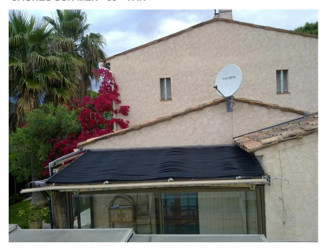
surface des capteurs moquettes correspond aux deux tiers de la surface de la piscine, une régulation et une pompe indépendante ainsi que deux sondes suffise à faire circuler l'eau de la piscine dans les capteurs moquettes, ceux ci permettent en plus de créer un ombrage fort appréciable l'été au dessus de la véranda, un gain de 4°c permet d'augmenter la durée de baignade, l'objectif principal est réalisé depuis 4 ans d'utilisation.
