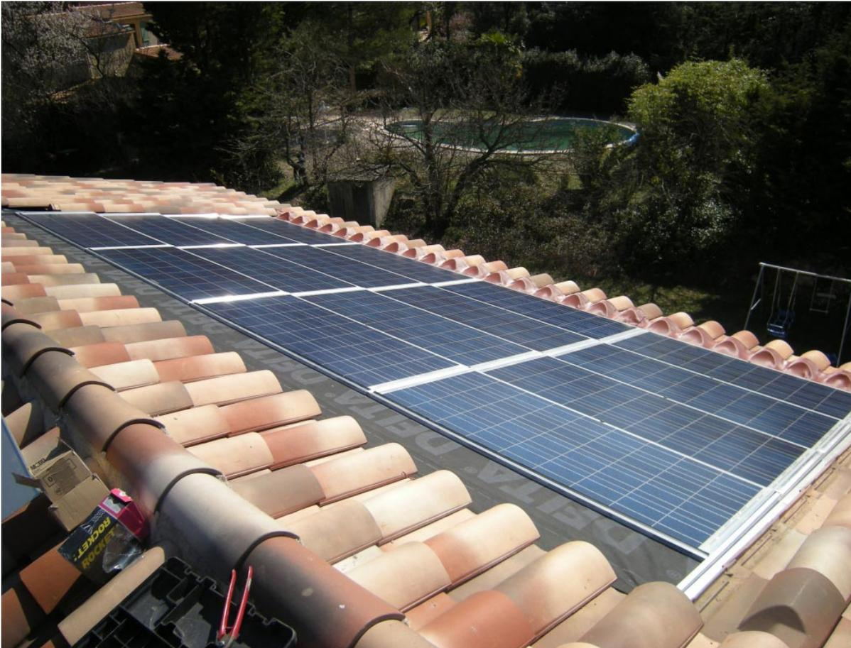
*16 panneaux SOLAR FABRIK de puissance 130 Wc associés à un onduleur SOLARMAX2000S*
