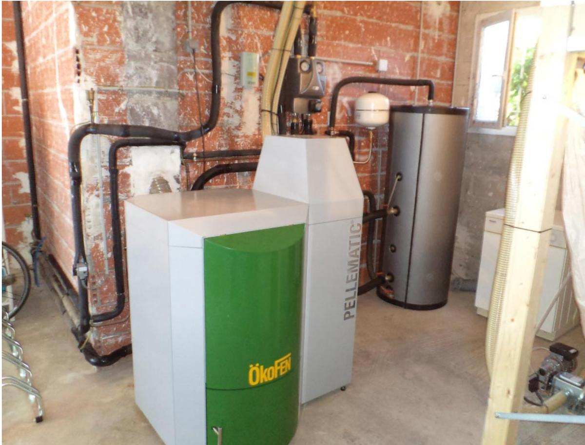
*Chaudière à granulés OKOFEN de puissance nominale 15 kw avec préparation d'eau chaude sanitaire (ballon 200 litres appoint électrique lors de l'arrêt de la chaudière) silo textile avec transfert des granulés par aspiration*
