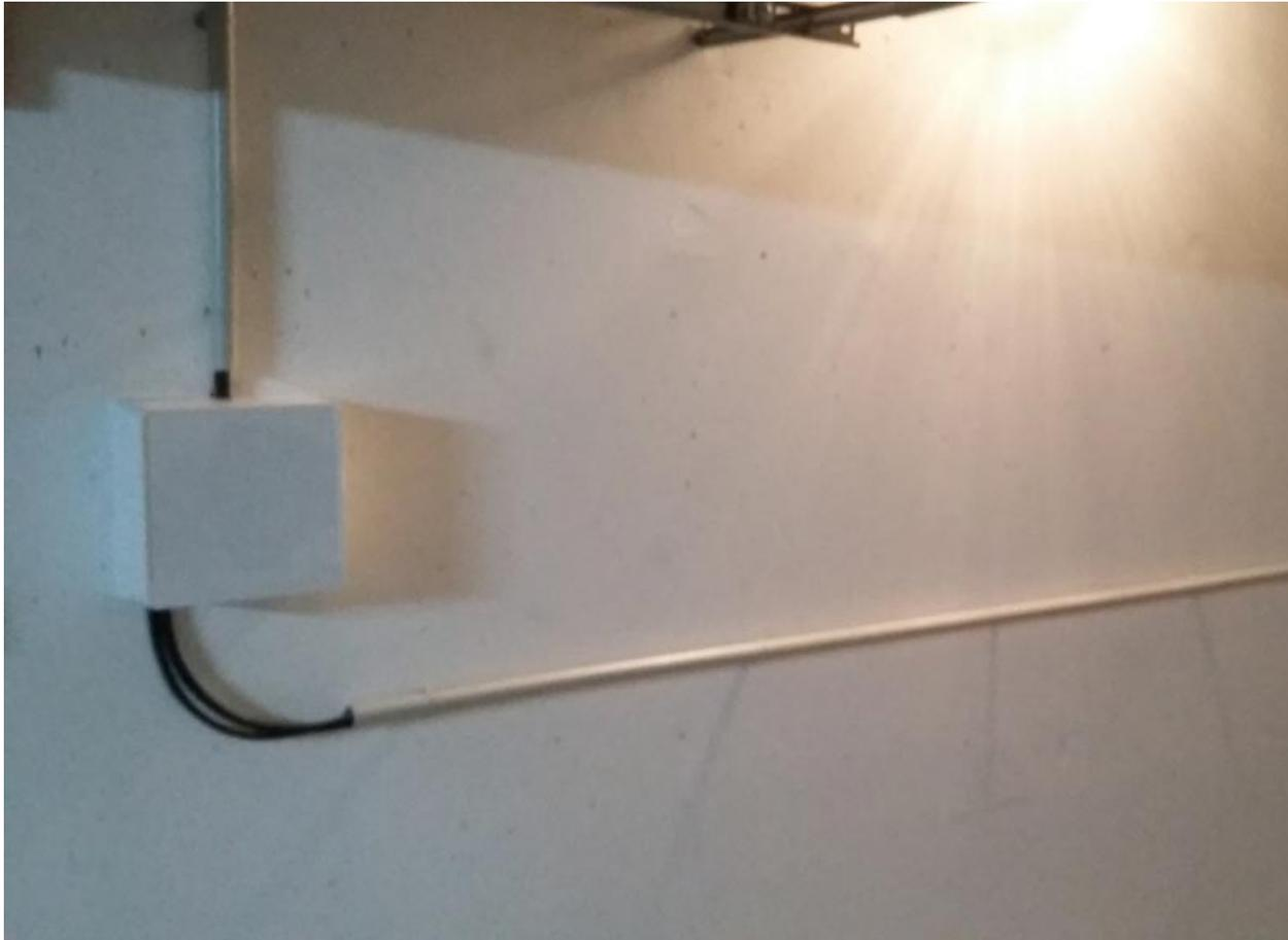
*Installation d'une borne de charge de véhicule électrique de marque HAGER modèle XEV92 7 kW*
